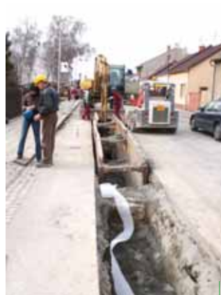
Rozkopané komunikace při pokládce nové kanalizace.
